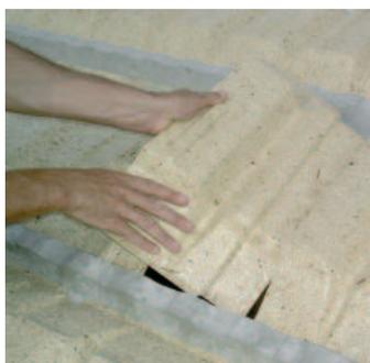
Dans le cas où une coupe est nécessaire (à réaliser toujours en partie haute, en suivant les tracés de prédécoupe), la partie restante (de longueur minimale de 20 cm) est suffisamment résistante pour être utilisée
