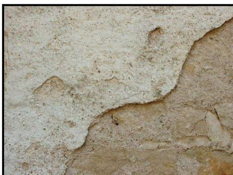
Enduit ancien se délitant et laissant apparaître ses différentes couches de l'enduit...
