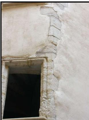
Enduit appliqué façon « dégradée », phénomène de harpage trop exagéré, qui efface toute la nervosité et la précision de l'architecture ...
